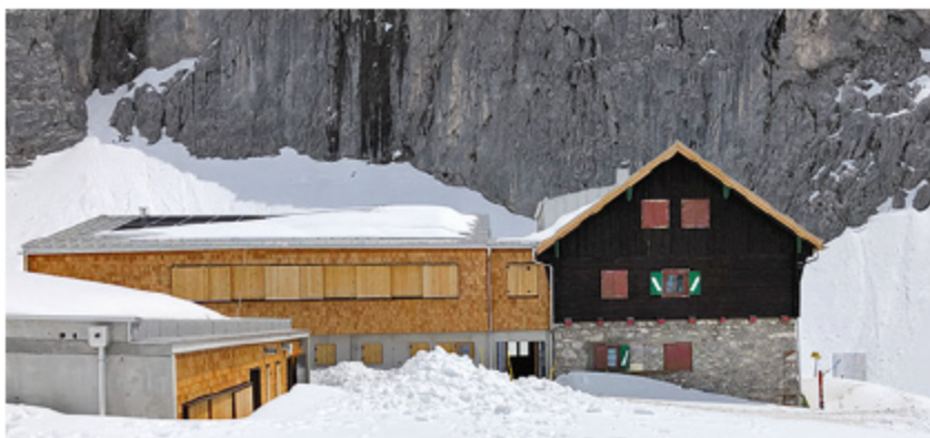
Verzögerungen auf der Baustelle: Im Mai lag für die letzten Arbeiten noch zu viel Schnee.
